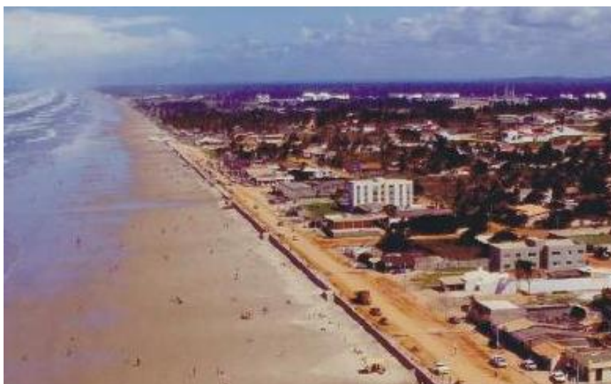
Figura 6.4. Aracaju. Construcción de la Avenida Santos Dumont, Playa de Atalaia
