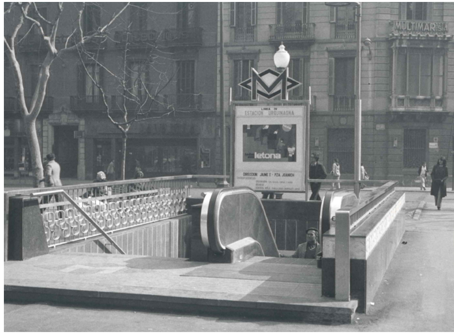
48. Acceso a la estación de Urquinaona en 1973 tras un cambio de diseño en la forma de los accesos e implementación de escaleras mecánicas. Fuente: Archivo TMB.
