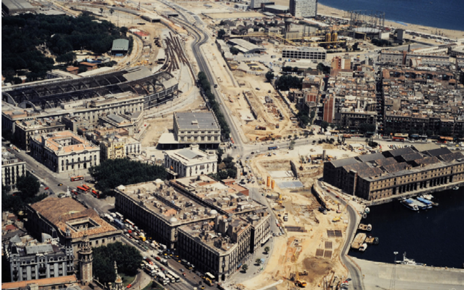
80. Foto aérea de las obras para los Juegos Olímpicos en la zona entre la Barceloneta y Plaza de Palacio en 1990. Se observa el corte de las vías de tren de la estación de Francia, la estación de Renfe - Cercanías a un lado, el trazado de la Ronda Litoral y el inicio de la formación de la Plaza de Pau Vila. Fuente: Archivo Municipal del Ayuntamiento de Barcelona.
