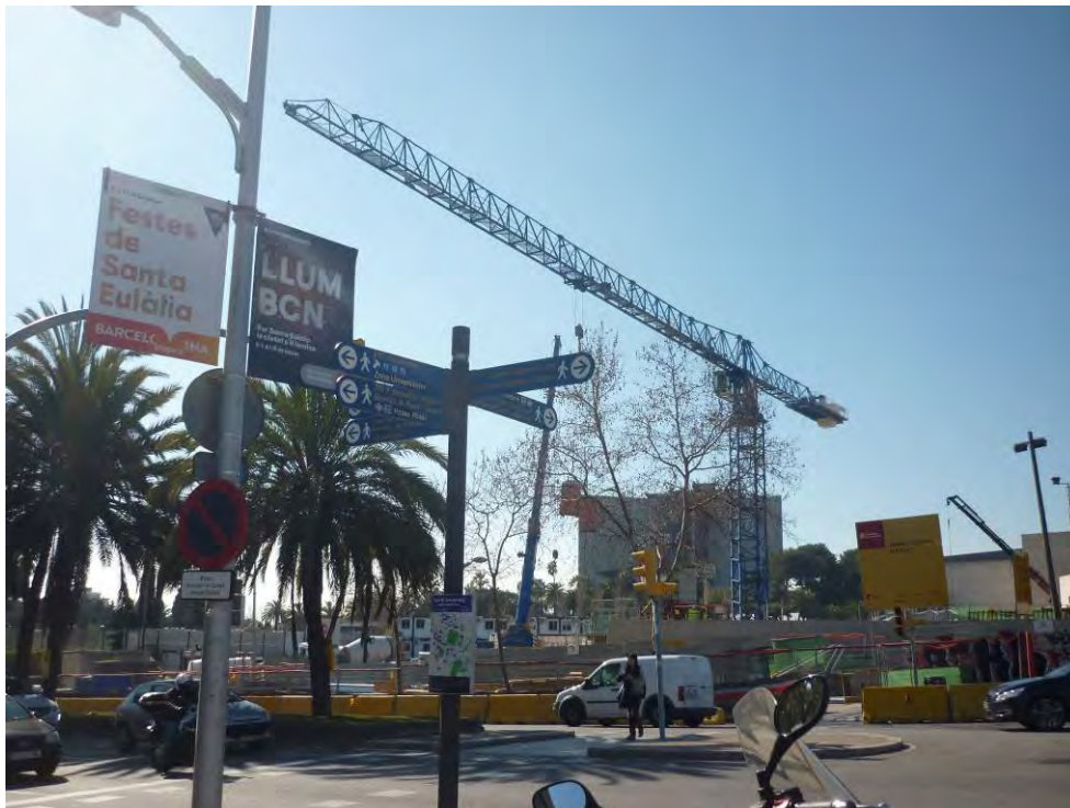
Figura 13. Obres de construcció de la L9 del metro a l'encreuament de l'av. Dr. Marañón amb l'av. Diagonal. La fotografia correspon a les proximitats del punt B3.
