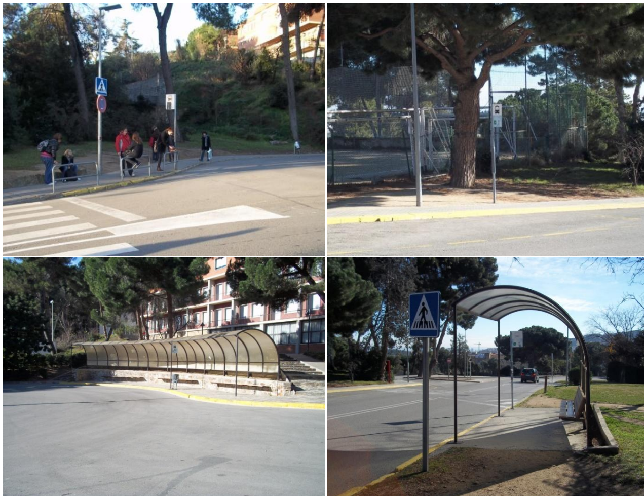
Figura 48. Parades de l'autobús intern del Campus: rotonda inferior (superior esquerra), edifici Migdia en sentit ascendent (superior dreta), rotonda superior (inferior esquerra) i edifici Migdia en sentit descendent (inferior dreta). Font: Banc d'imatges OSSMA (12/01/2011).
