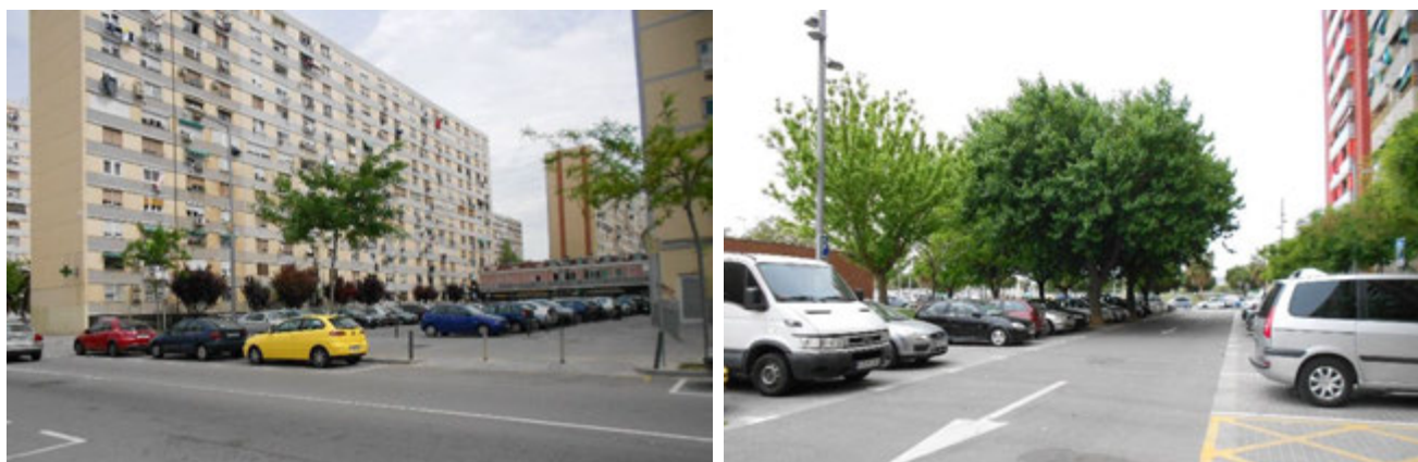
Figura 17. Espais d'aparcament al costat d'habitatges a l'Av. Mare de Déu de Bellvitge. Font: Banc d'imatges de l'OSSMA (05/05/15).
