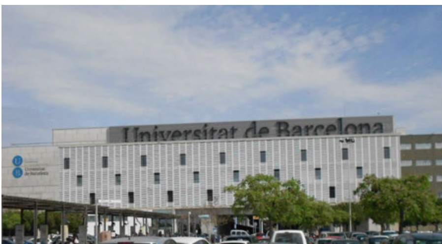
Figura 2. Façana del nou Aulari de Bellvitge. Font: Banc d'imatges de l'OSSMA (05/05/15).
