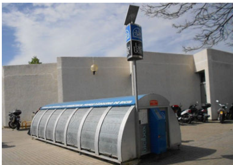
Figura 33. Aparcament segur de bicicletes Bicibox (número 075) situat al recinte de l'Hospital Universitari de Bellvitge. Font: Banc d'imatges de l'OSSMA (05/05/15).
