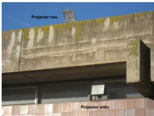
Figura 35. Substitució de projectors d'il·luminació exterior a l'edifici 690 d'Economia i Empresa. Font: Unitat de Manteniment de l'Àrea d'Infraestructures i Serveis - Pla Pluriennal.
