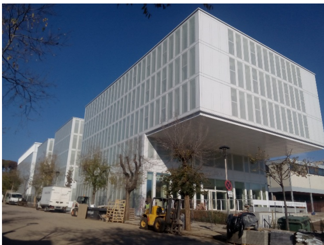
Figura 11. Nou edifici de la Facultat de Dret. Banc d'imatges OSSMA.
