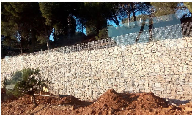
Figura 12. Obres de la via ciclable entre Esplugues de Llobregat i Barcelona, al costat del Campus Diagonal. Banc d'imatges OSSMA.
