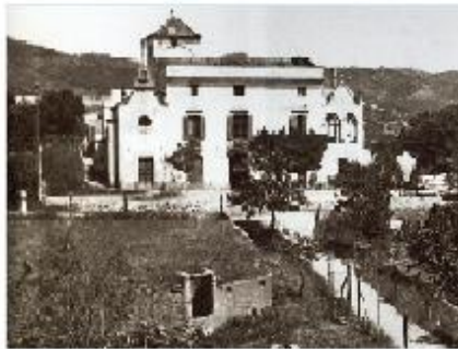
3. Can Grau, masía del s. XVI, derribada en 2006
