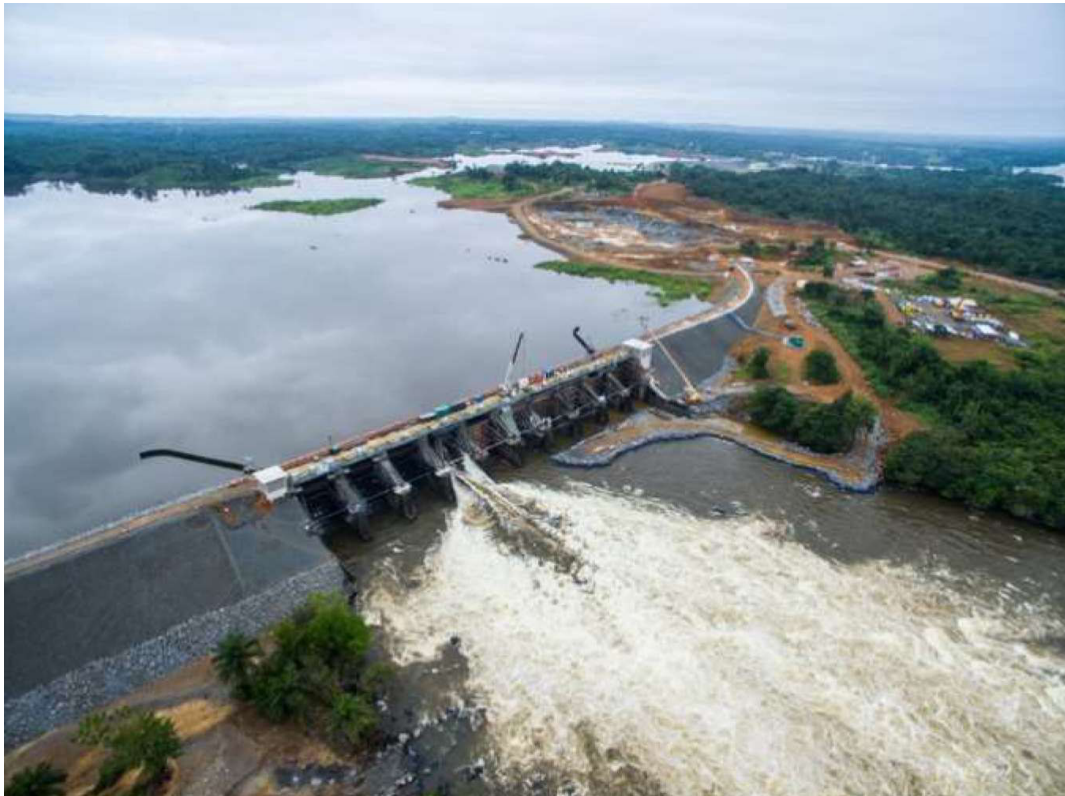
Imagen 3 Central hidroeléctrica de Mt. Coffe.
