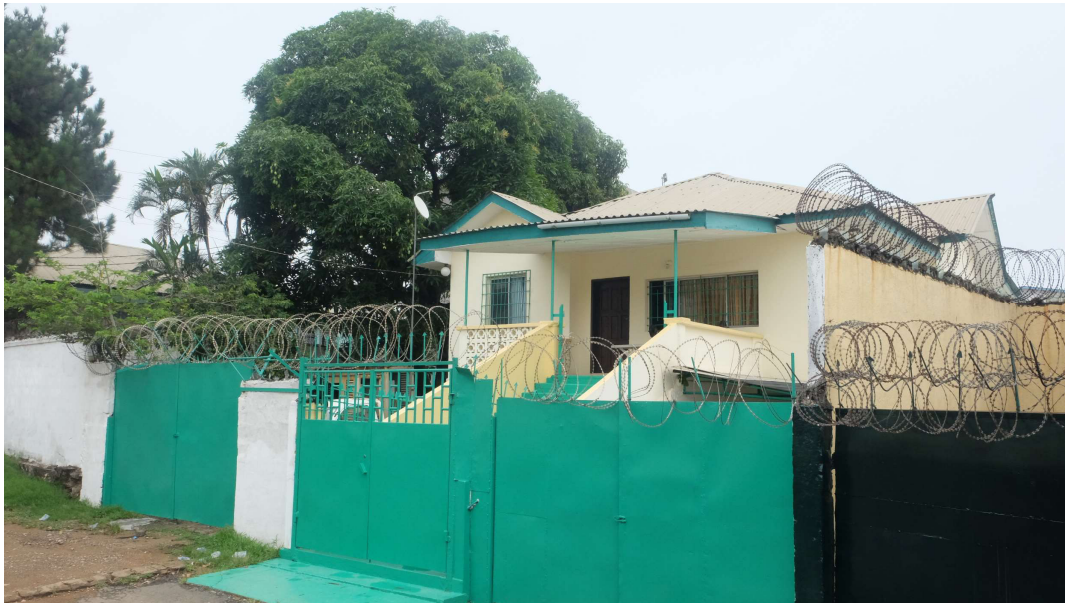
Imagen 6 Vista general de la vivienda, entrada lado sur.
