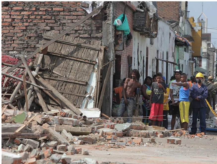
Ilustración 10. Demoliciones barrio el Calvario
