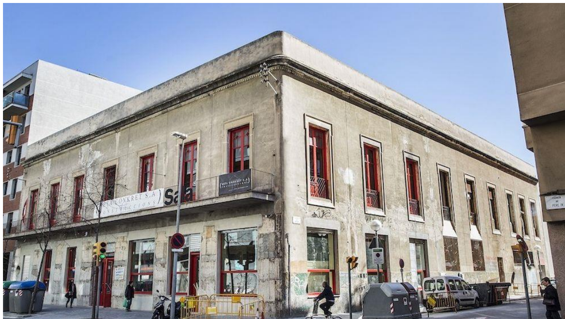
Imatge de l'edifici adquirit per Pau i Justícia el 1910. Realitzada el mes de març del 2016, abans de convertir-se en la nova sala Beckett de Barcelona. Extreta de: < http://www.ara.cat/cultura/Aixi-sera-nova-Sala-Beckett_0_1532846752.html >.
