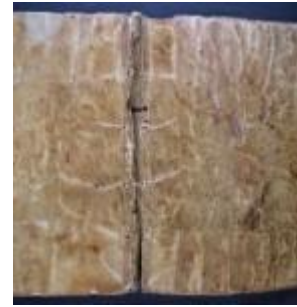
Llom i cobertes
