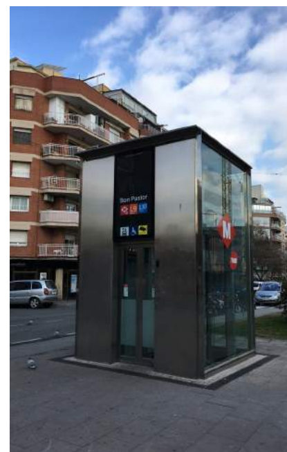
Fig. 29: Ascensor metro de Bon Pastor Fotografía de la autora
