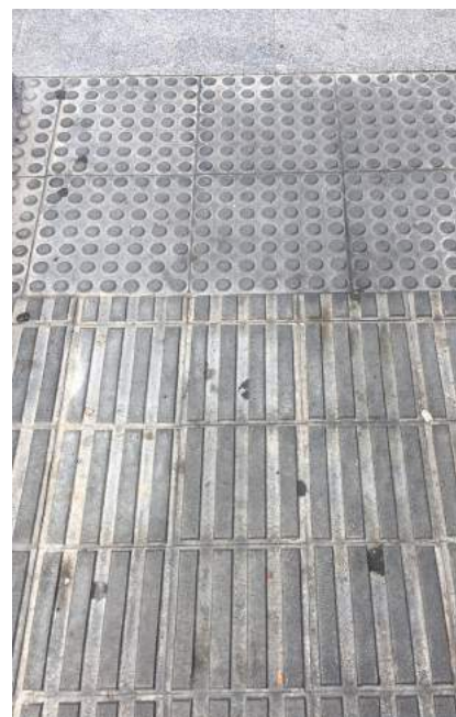
Fig. 27 : Pavimento podó táctil Fotografía de la autora
