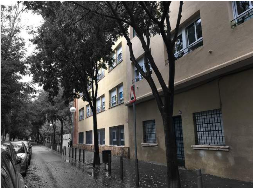
Fig. 111: Plano vertical calle d'Estadella (lado sur). Edificio alto que se conecta a la calle por medio de las ventanas. Fotografía de la autora Edición propia
