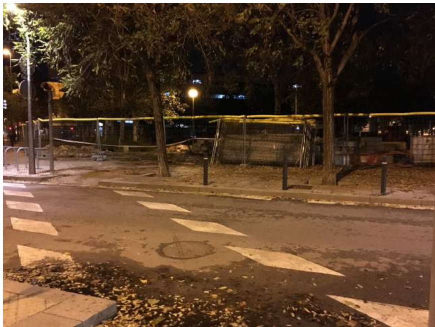
Fig. 142: Plaza Joan Mossèn Cortinas en rehabilitación Fotografía de la autora
