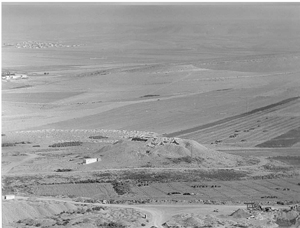
Fig. 8. Panorámica general de Tell Jamis tras la primera campaña de excavaciones (1992)
