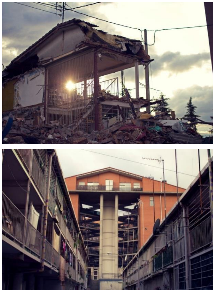
Figura 27. Las Unidades de Viviendas de Absorción (Manteras, Madrid), en proceso de desmantelamiento.
