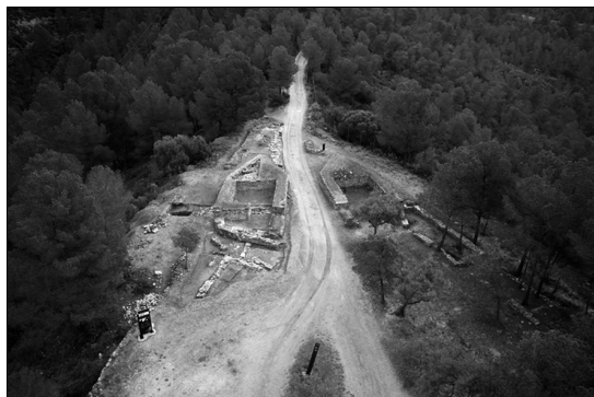
Figura 5. Vista de las torres pentagonales desde el oeste.
