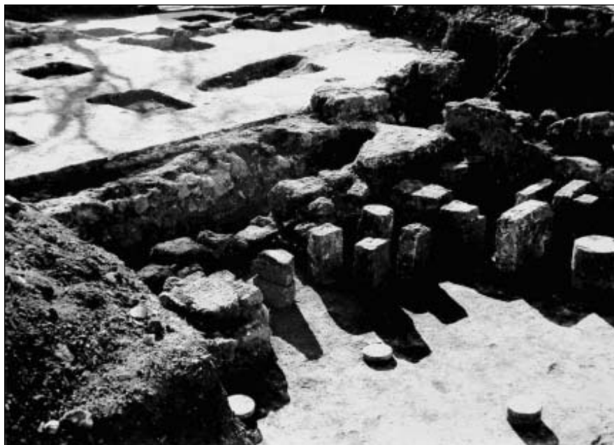
Figura 11. Excavación en Santa Anna de Ca'n Costa, con un presunto hypocaustum (1934). Foto: Isasi, s.d.-c: 79. © Museu de Mallorca.
