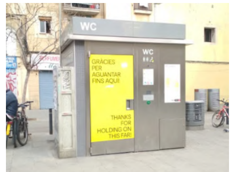
Batería sanitaria en plaza Salvador Seguí
