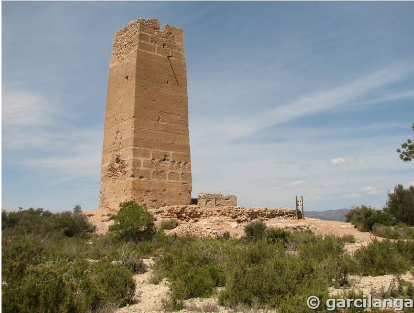
Fig. 36. Torre Bofilla a Bétera amb la tècnica del “falso despiece de sillería”.
