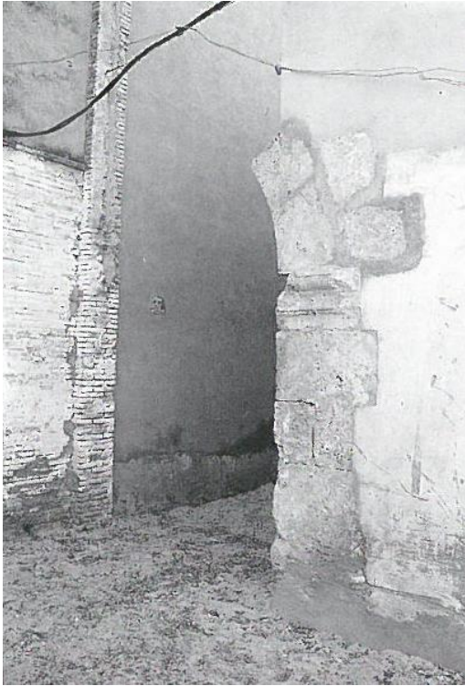
Fig. 30 i 31. Arranc d'un arc, amb els salmers i la imposta descobert durant l'enderroc de les cases al voltant del 1980. Font: Cebrián, 1989, 30 i 32.
