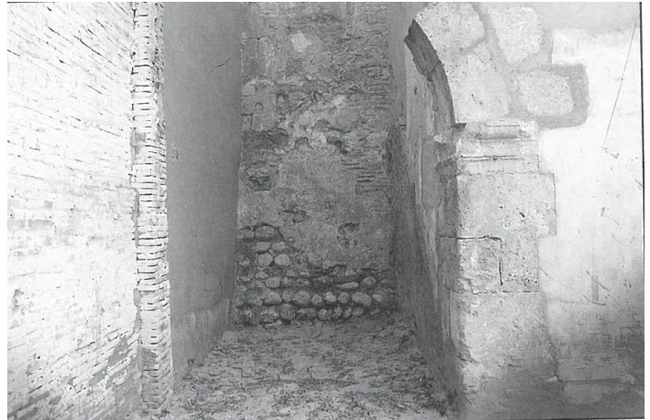
Fig. 30 i 31. Arranc d'un arc, amb els salmers i la imposta descobert durant l'enderroc de les cases al voltant del 1980. Font: Cebrián, 1989, 30 i 32.
