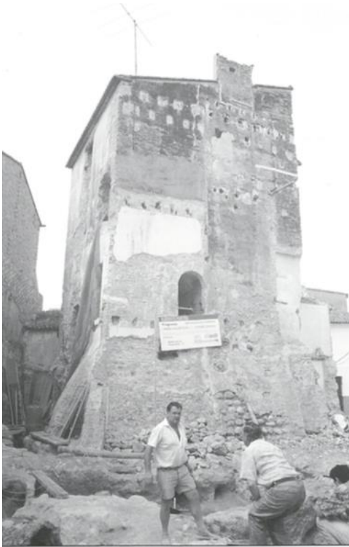
Fig. 51. Cara nord-est de la Torre de Canals abans de la seua restauració. Font: Cebrián, 1994, 2.
