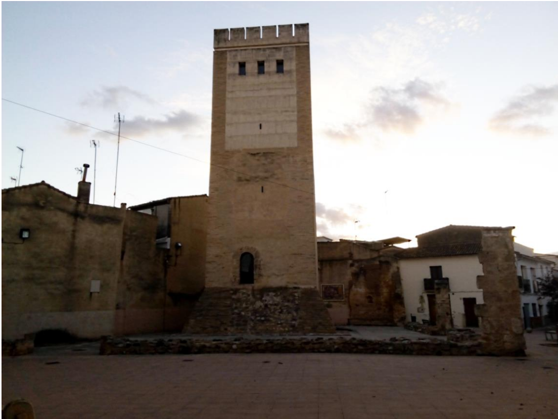
Fig. 53. Aspecte de la Torre de Canals hui en dia, amb les restes de l'estructura de la cantonada i l'arrancada d'arc.
