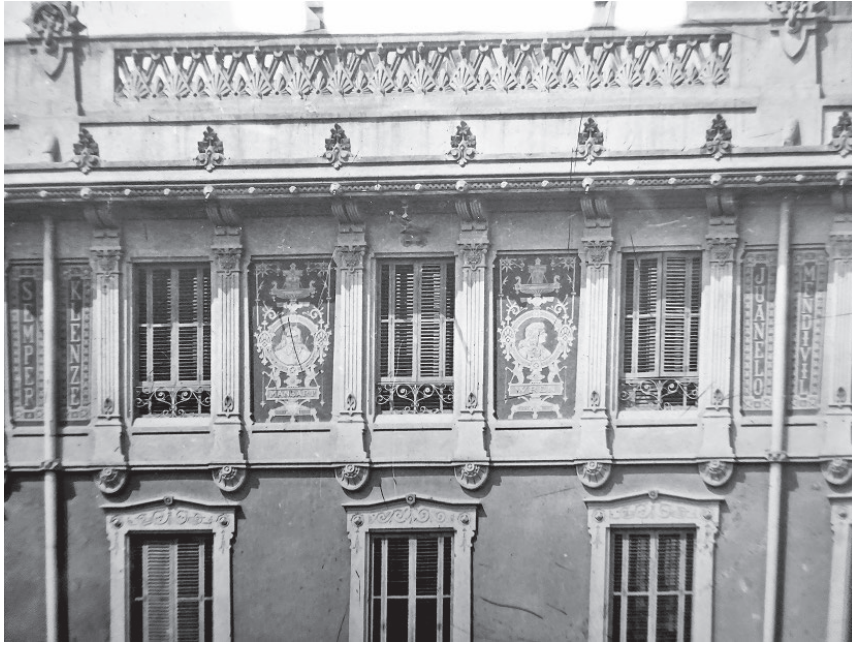
Detalle de la planta superior de la fachada de la calle Trafalgar, en la que se observan los nombres y retratos de arquitectos insignes de tradición ecléctico-renacentista. Fuente: George R. Collins Archive of Catalan Art and Architecture, Ryerson and Burnham Archives, The Art Institute of Chicago.
