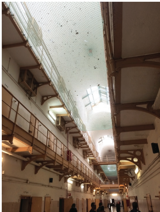
Perspectiva interior de uno de los aleros del panóptico de la Modelo. Foto: S. Fuentes.
