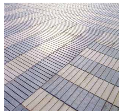
5.2.10. Losas vibrazo relieve para la señalización para los pasos de peatones.
