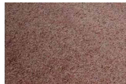
5.1.6. Detalle asfalto rojo
