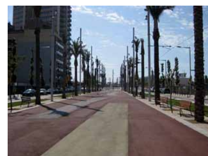
5.2.9. Ejemplo pavimentación asfalto de colores la Rambla de la Mina
