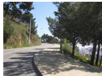
5.1.10. Ejemplo acera Carretera Alta de Roquetes
