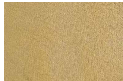
5.1.7. Detalle hormigón coloreado ocre
