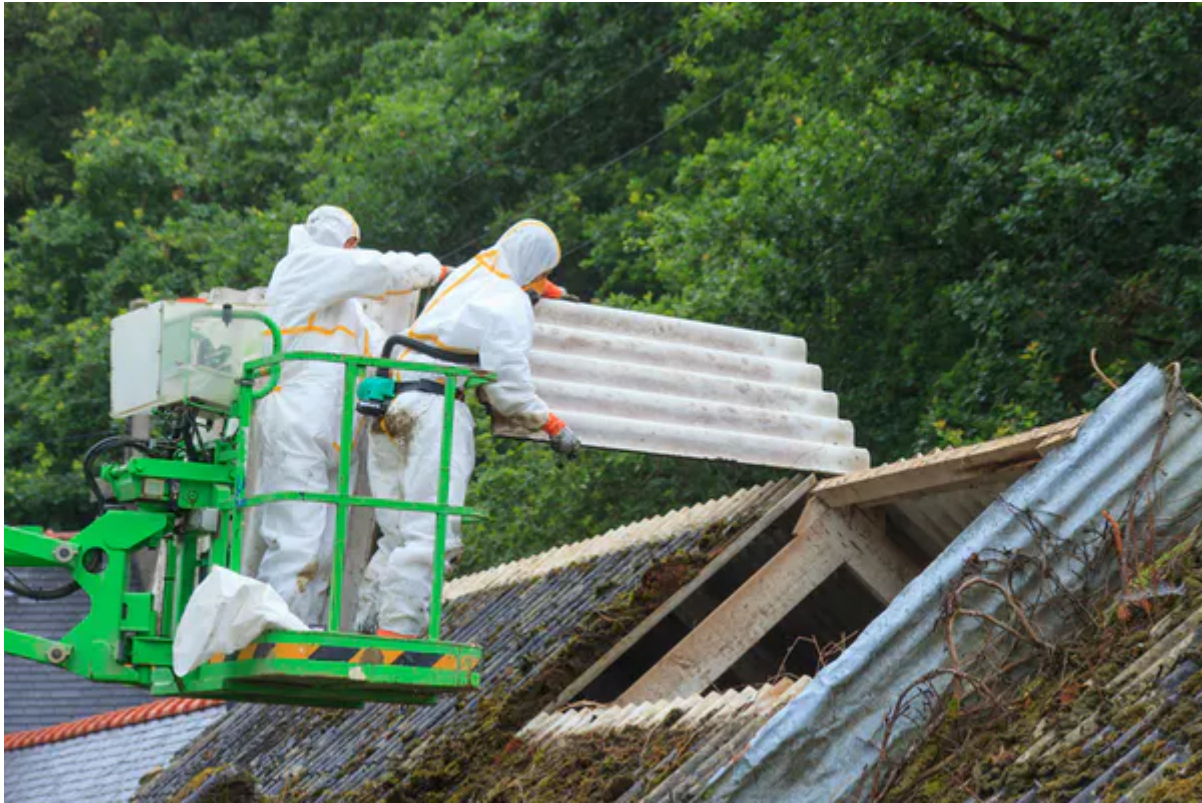
Trabajadores eliminan estructuras con amianto. Shutterstock/andre quinou
