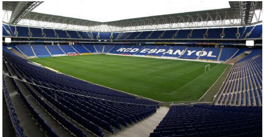
Il·lustració 14. – Vista interior del RCDE Stadium
