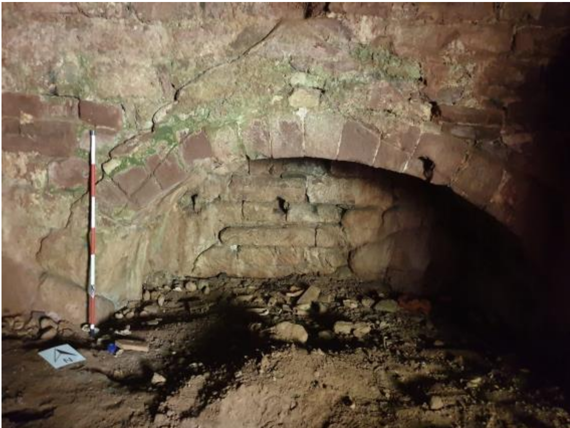
Fig. 37: Imatge de l'interior de l'espai, on està el canal del cup tapiat, al fons de la galeria.
