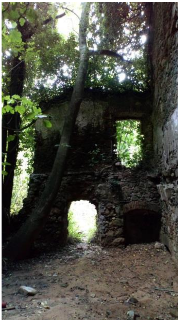
Fig. 21: Façana d'una de les sales, concretament la de l'interior a mà dreta. Està a una cota superior respecte a l'altre, la sala esquerra, on hi hauria les moles (vegeu a l'annex, figures 22, 23, 24 i 25).
