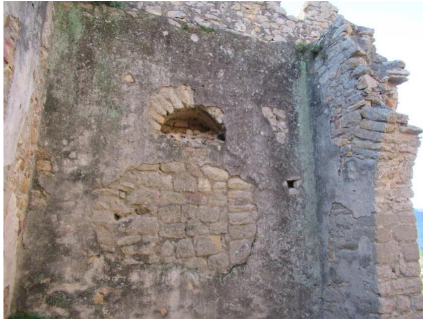
Fig. 12. Paret Sud de la sala noble on s'observa una finestra tapiada, l'arrencament de la volta i l'emblanquinat de les parets. Font: A. Vilella
