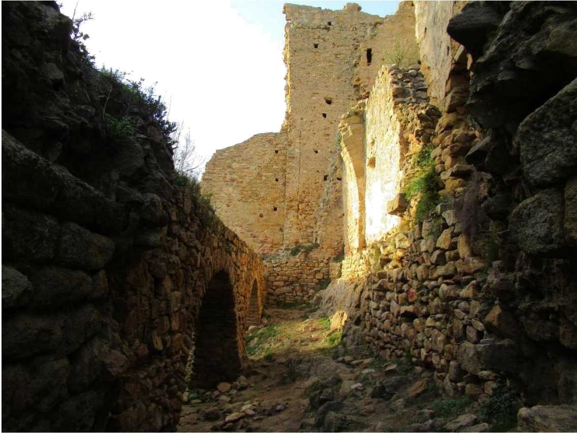
Fig. 11. Sala noble i celler on s'observen les arcades que marcarien el nivell de circulació del pis superior i els arcs. Font: A. Vilella
