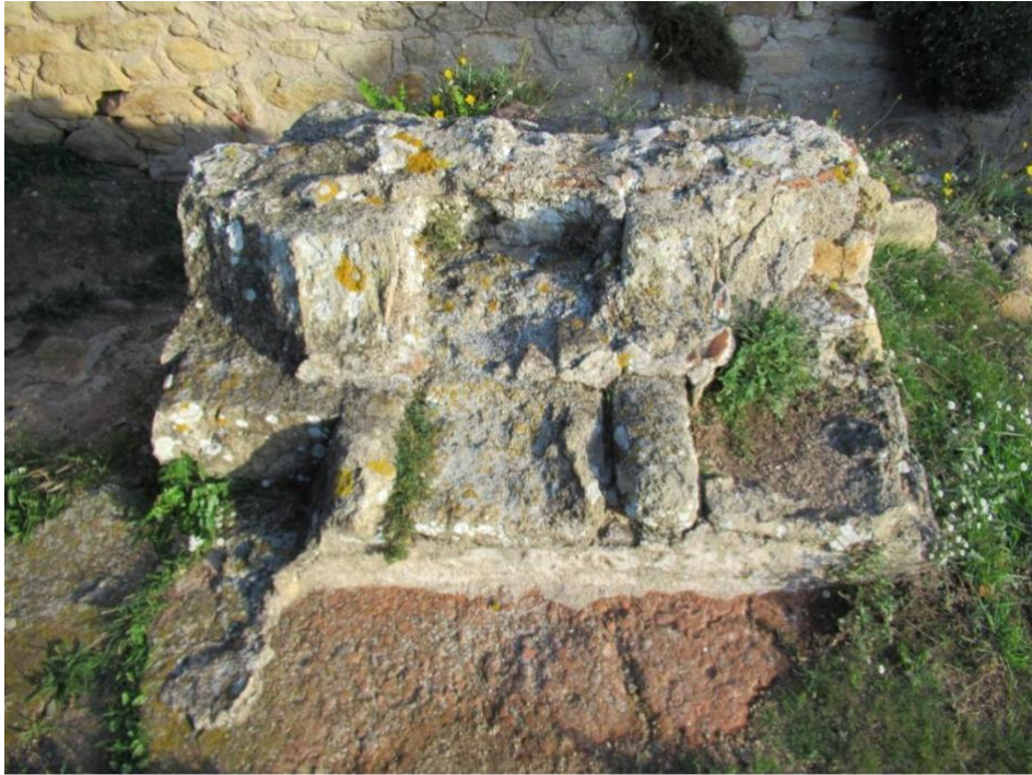
Fig. 15. Canalització situada sobre la cisterna. Font: A. Vilella
