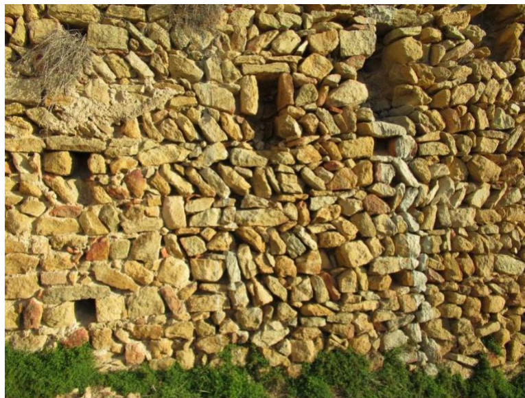
Fig. 1. Detall de l' opus spicatum situat a la torre Oest. Font: A. Vilella
