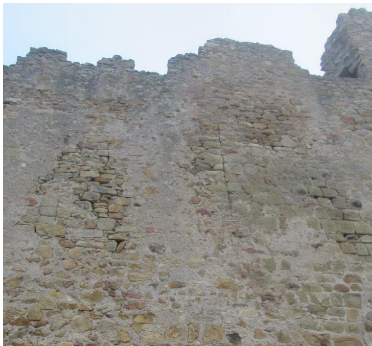
Fig. 22. Línia que evidencia la separació dels murs de la porta i de la sala noble. Font: A. Vilella
