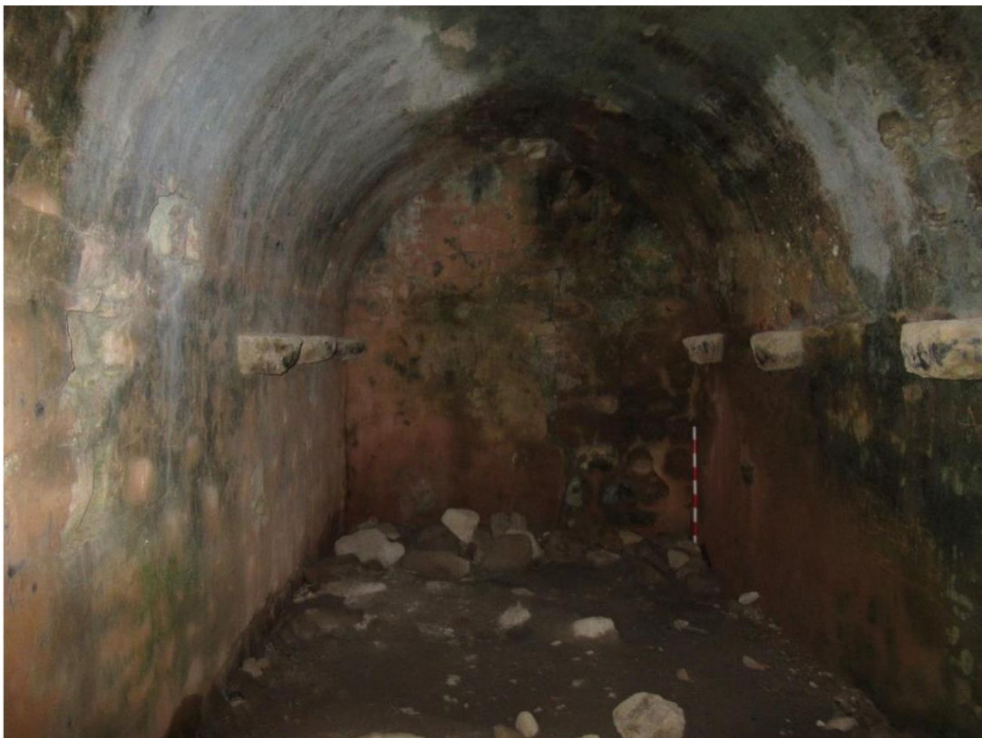
Fig. 14. Interior de la cisterna on s'aprecien les mènules i el revestiment impermeable. Font: A. Vilella
