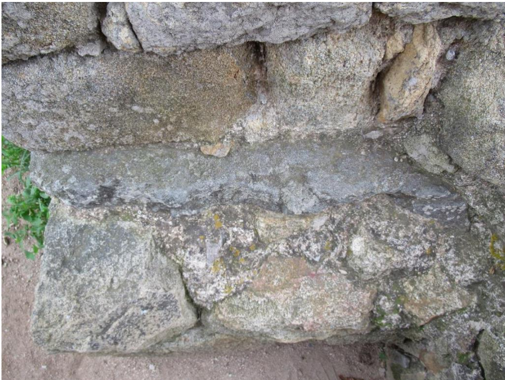
Fig. 6. Detall de l'espoli que afecta al festejador de la torre Oest, on s'aprecien les marques d'extracció. Font: A. Vilella
