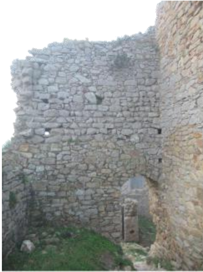
Fig. 27. Entrada reconstruïda del recinte sobirà superior. Font: A. Vilella
