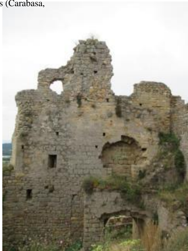
Fig. 21 . Muralla del recinte sobirà inferior on s'aprecia la porta amb rastell, el pas de ronda amb l'escala i les mènsules. Font: A. Vilella
