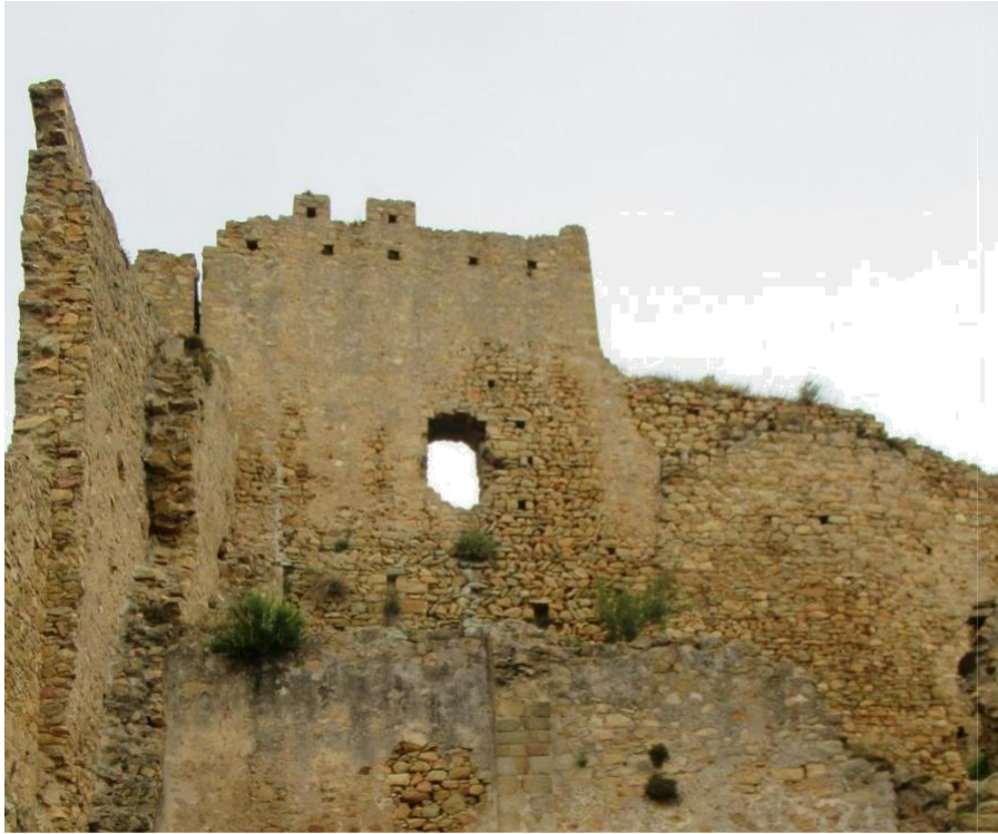
Fig. 25. Torre de l'homenatge sencera vista des de l'exterior. Font: A. Vilella
