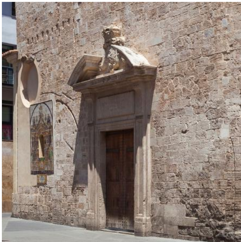
Figura 64. Detall de la façana principal de l'església de Santa Caterina (València). A mà esquerra hi ha encara els forats de les bigues de la llotgeta del mostassà de la ciutat, a més dels arcs tapiats. Fotografia de Pablo José Alcover.
