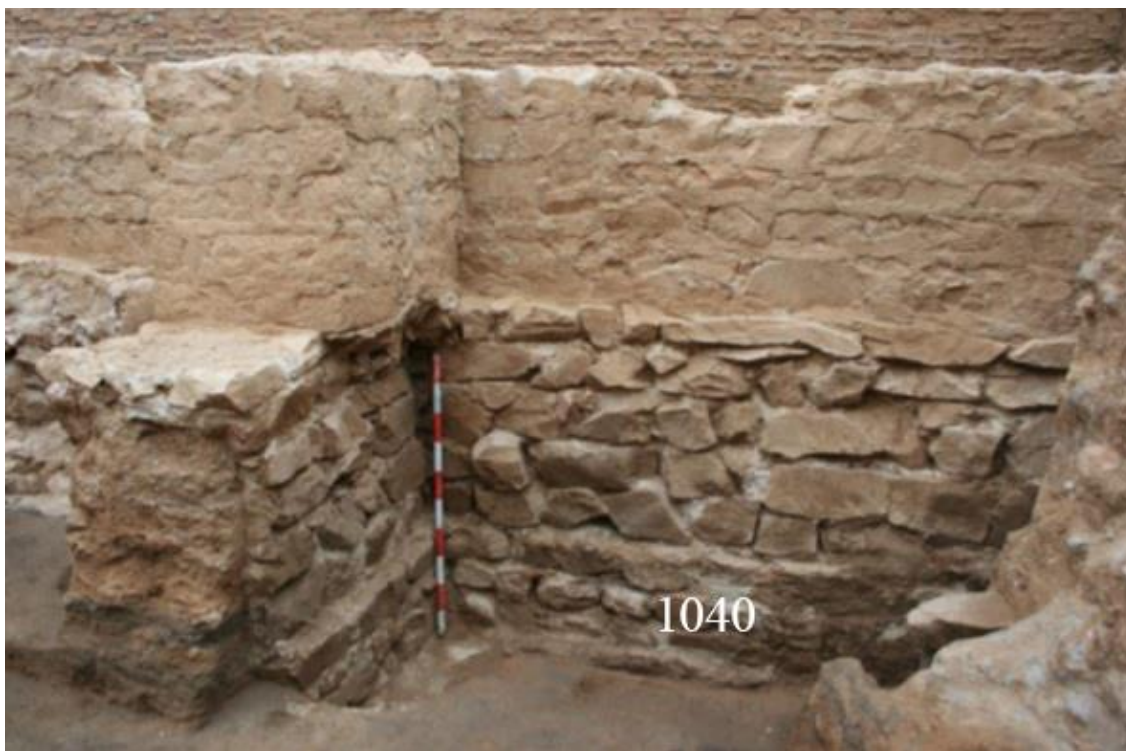
Figura 42. Fotografia de la fonamentació UE 1040 modificada per l'autor (Sánchez, 2011: 168).
