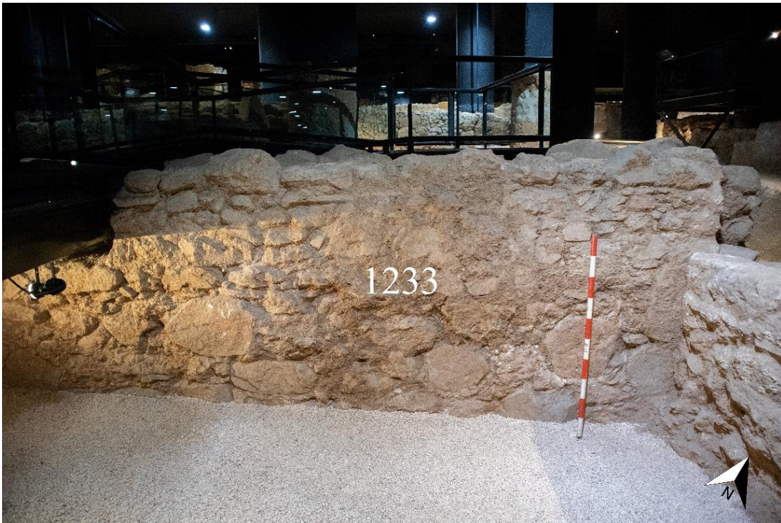
Figura 55. Fotografia del mur UE 1233 (Autor).
