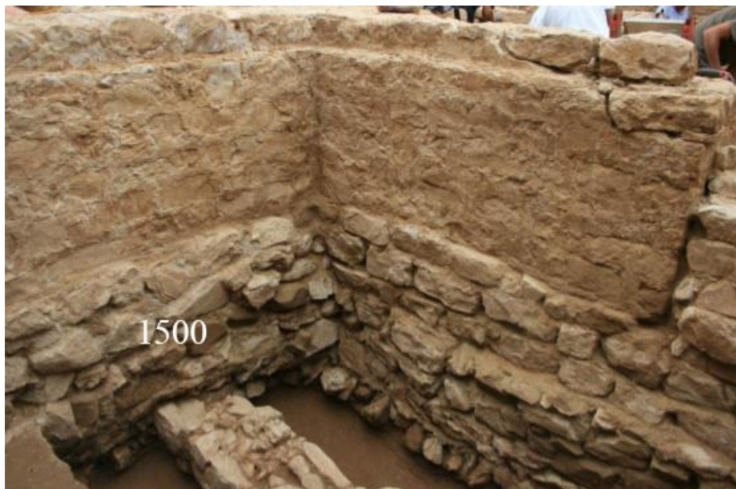
Figura 73. Fotografia de la fonamentació UE 1500 modificada per l'autor (Sánchez, 2011).
