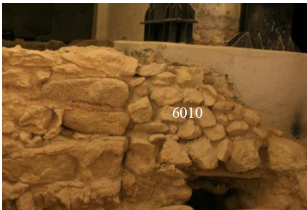
Figura 100. Fotografia del mur UE 6010 modificada per l'autor (Fernández i Sánchez, 2008-2009).
