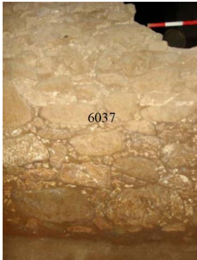
Figura 107. Fotografia del mur UE 6037 modificada per l'autor (Fernández i Sánchez, 2008-2009).
