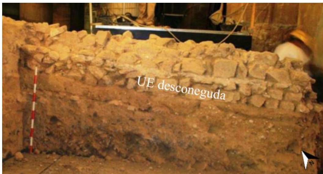
Figura 118. Fotografia de la fonamentació UE desconeguda modificada per l'autor (Fernández et al, 2009-2010).
