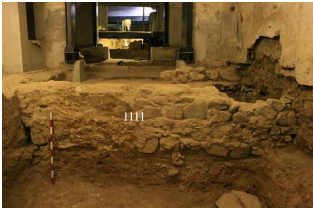
Figura 47. Fotografia del mur UE 1111 modificada per l'autor (Fernández i Sánchez, 2008-2009).
