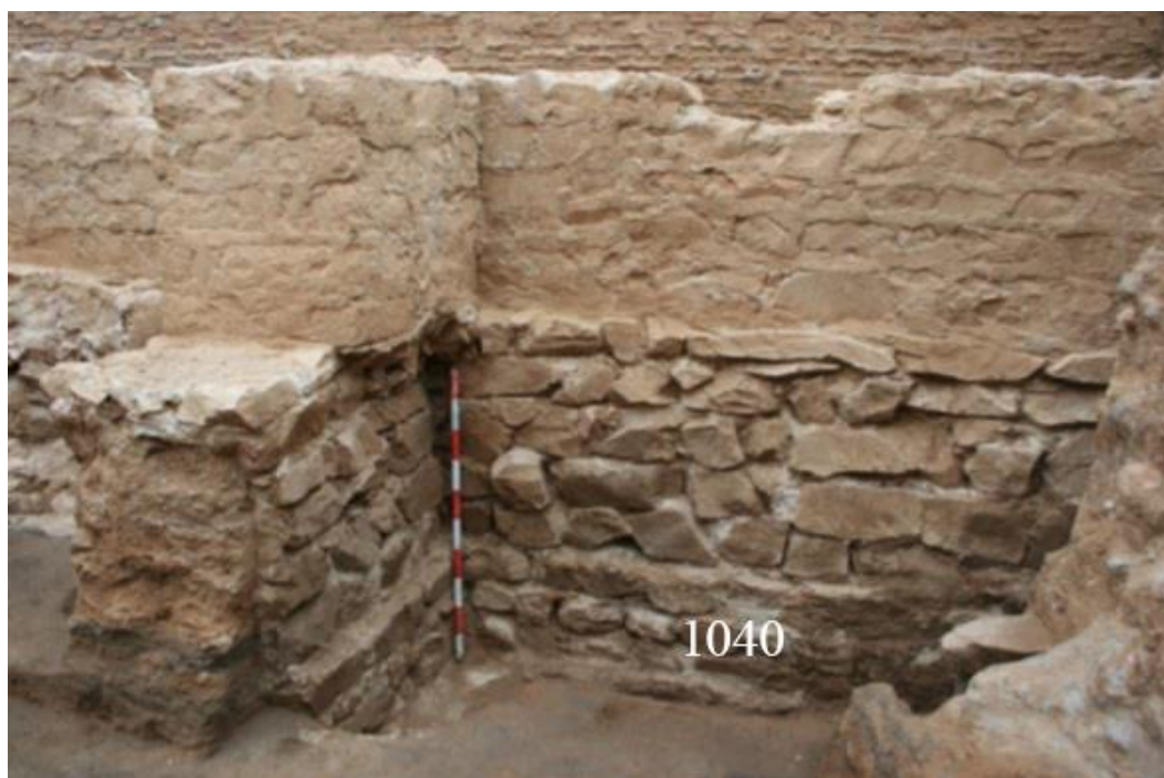
Figura 42. Fotografia de la fonamentació UE 1040 modificada per l'autor (Sánchez, 2011).
