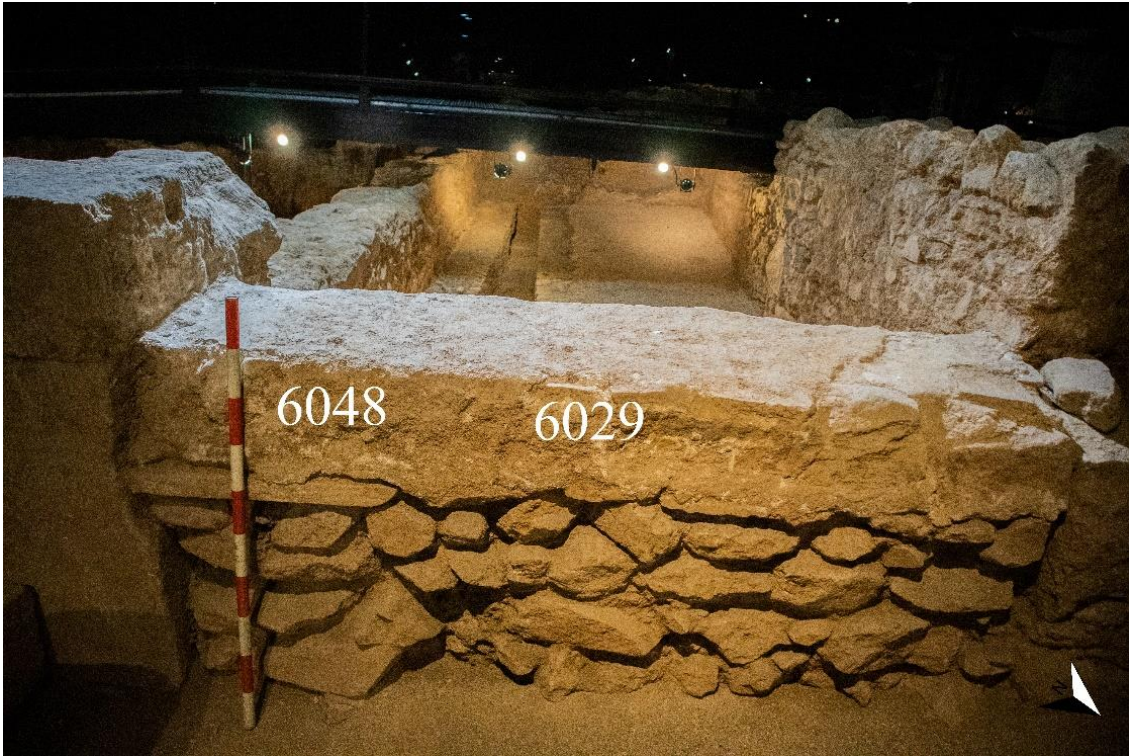
Figura 104. Fotografia del mur UE 6029 i el revestiment UE 6048 (Autor).
