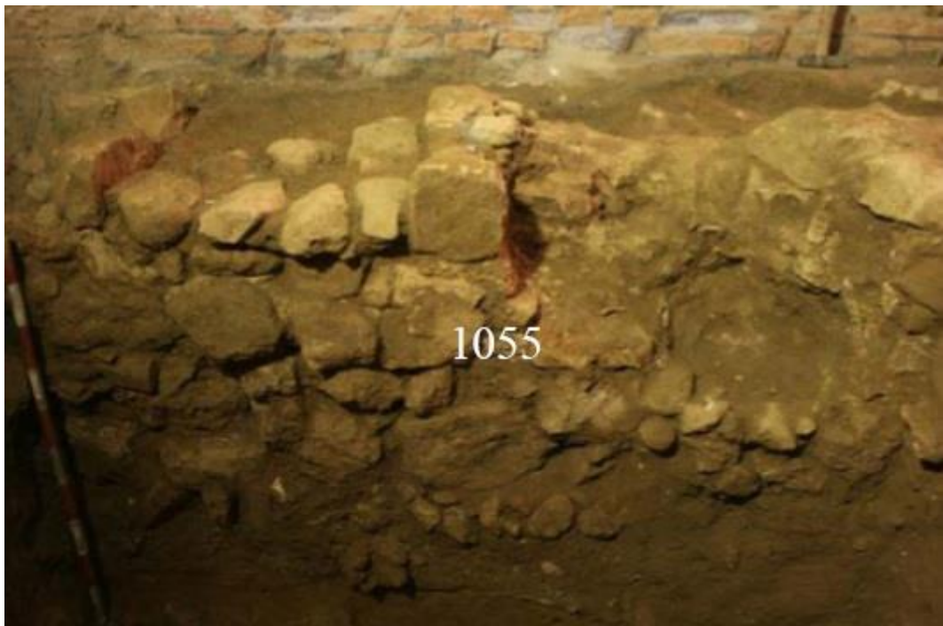
Figura 44. Fotografia del mur UE 1055 modificada per l'autor (Fernández i Sánchez, 2008-2009).
