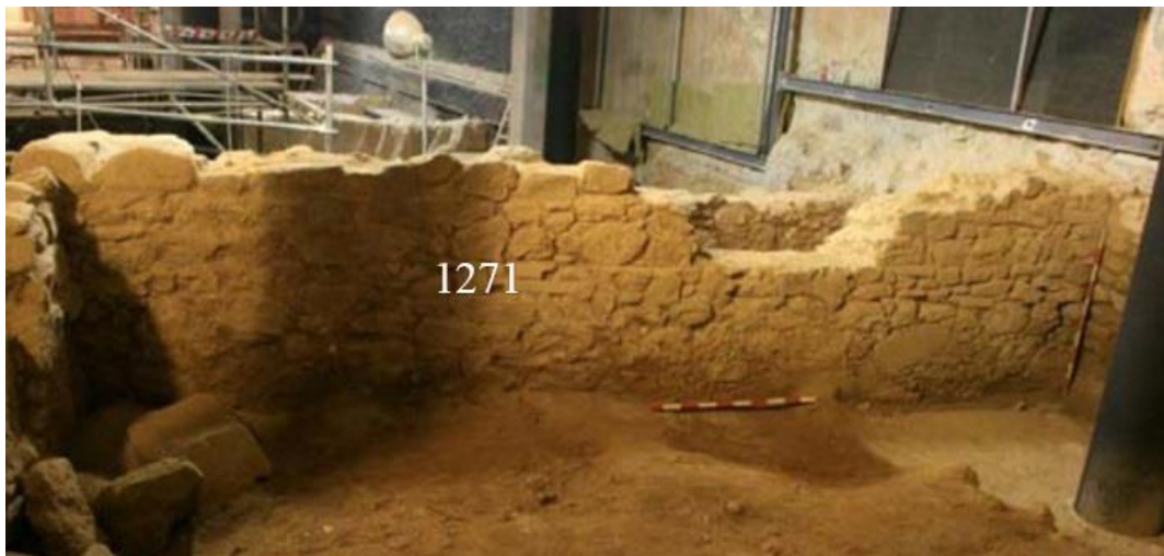
Figura 56. Fotografia del mur UE 1271 modificada per l'autor (Fernández i Sánchez, 2008-2009).
