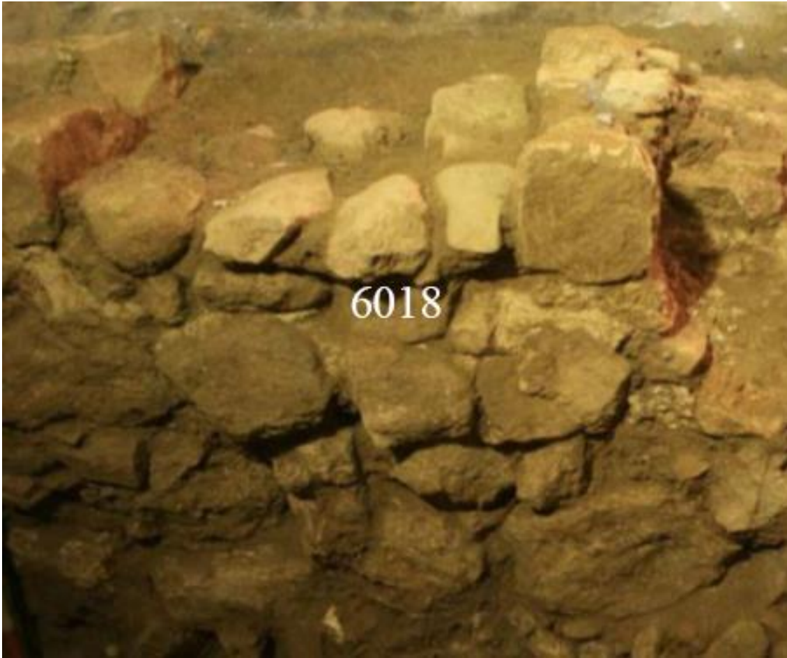
Figura 101. Fotografia del mur UE 6018 modificada per l'autor (Fernández et al, 2008-2009: 42).
