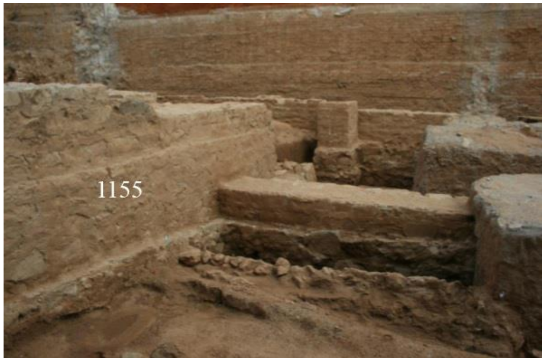
Figura 49. Fotografia de la fonamentació UE 1155 modificada per l'autor (Sánchez, 2011).
