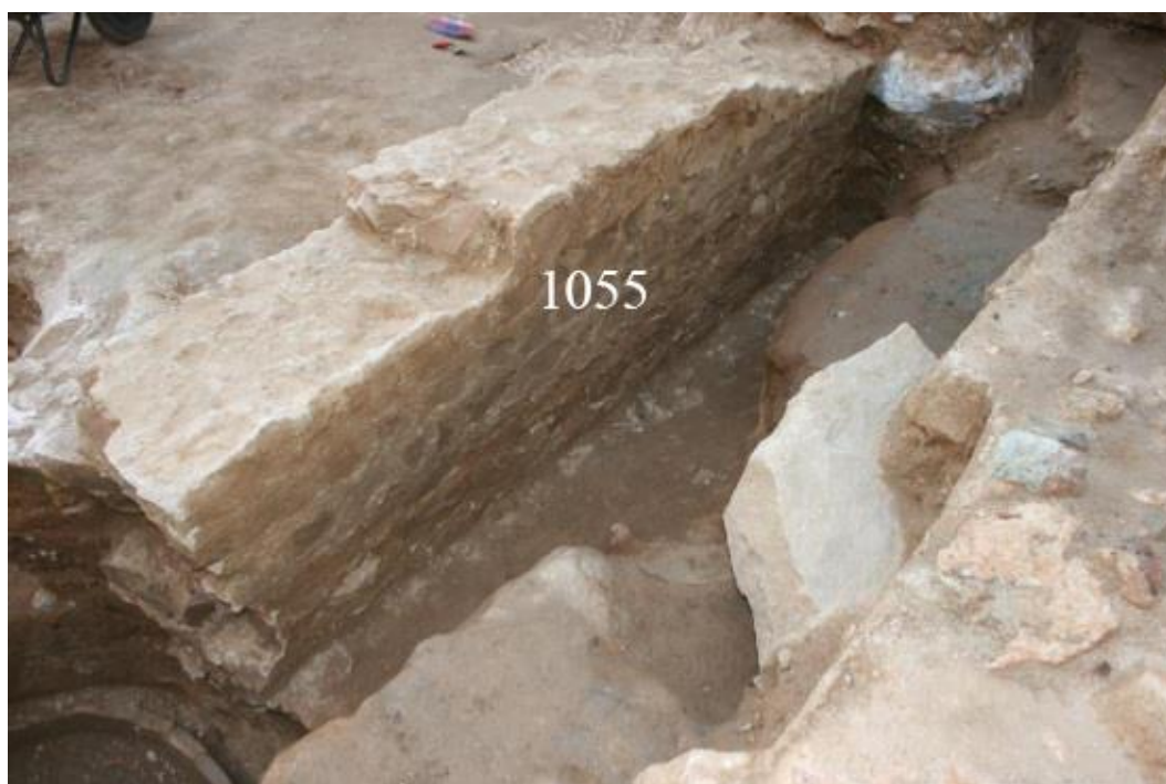
Figura 45. Fotografia de la fonamentació UE 1055 modificada per l'autor (Sánchez, 2011).
