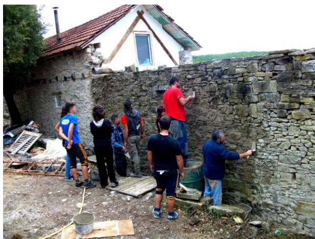
Imatge 3: Restauració d'un mur a Aizkurgi (2011). Font: aizkurgi.blogspot
