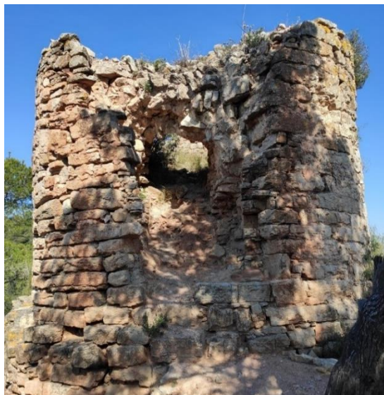
Fig. 8 Fotografia d'autoria pròpia, sobre l'entrada a la torre, molt enrunada i sense conservar la volta. Fotografia pròpia
