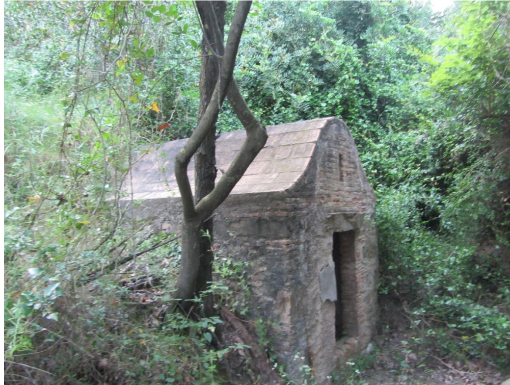
Punt de distribució d'aigua. S'han localitzats fins a tres d'aquestes construccions amb idèntica arquitectura. Moltes d'aquestes infraestructures han quedat afectades a causa de l'extracció de calcàries de l'empresa Sànsen.
