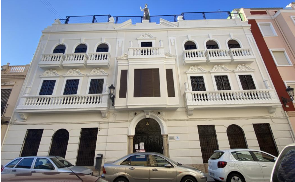
Figura 13: Fachada principal del Colegio Santiago Apóstol. Fuente: elaboración propia.
