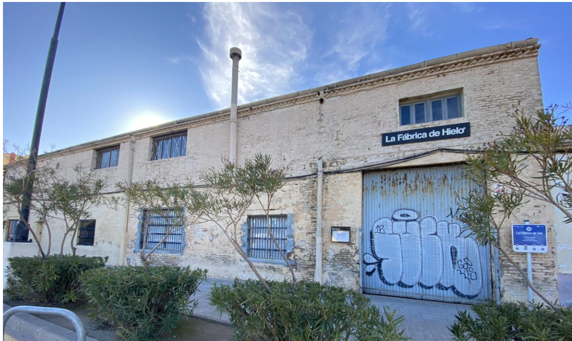
Figura 17: Fachada Fábrica de Hielo calle Eugenia Viñes. Fuente: elaboración propia.
