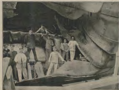
Altre aspecte de l'avaría
