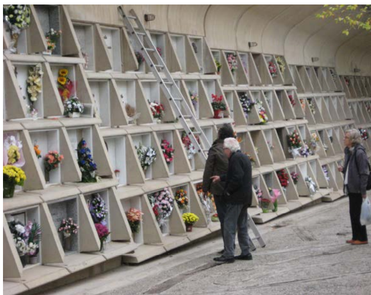
Fig.54. Garcia-Torra (2017). Talussos de nínxols. Cementi Nou. Igualada
