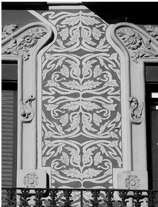
Detalle de la fachada principal de la casa Josep Magret, ubicada en la calle Atlántida, núm. 47 de Barcelona, proyectada por Josep Graner i Prat en 1900. Foto de Daniel Pifarré.
