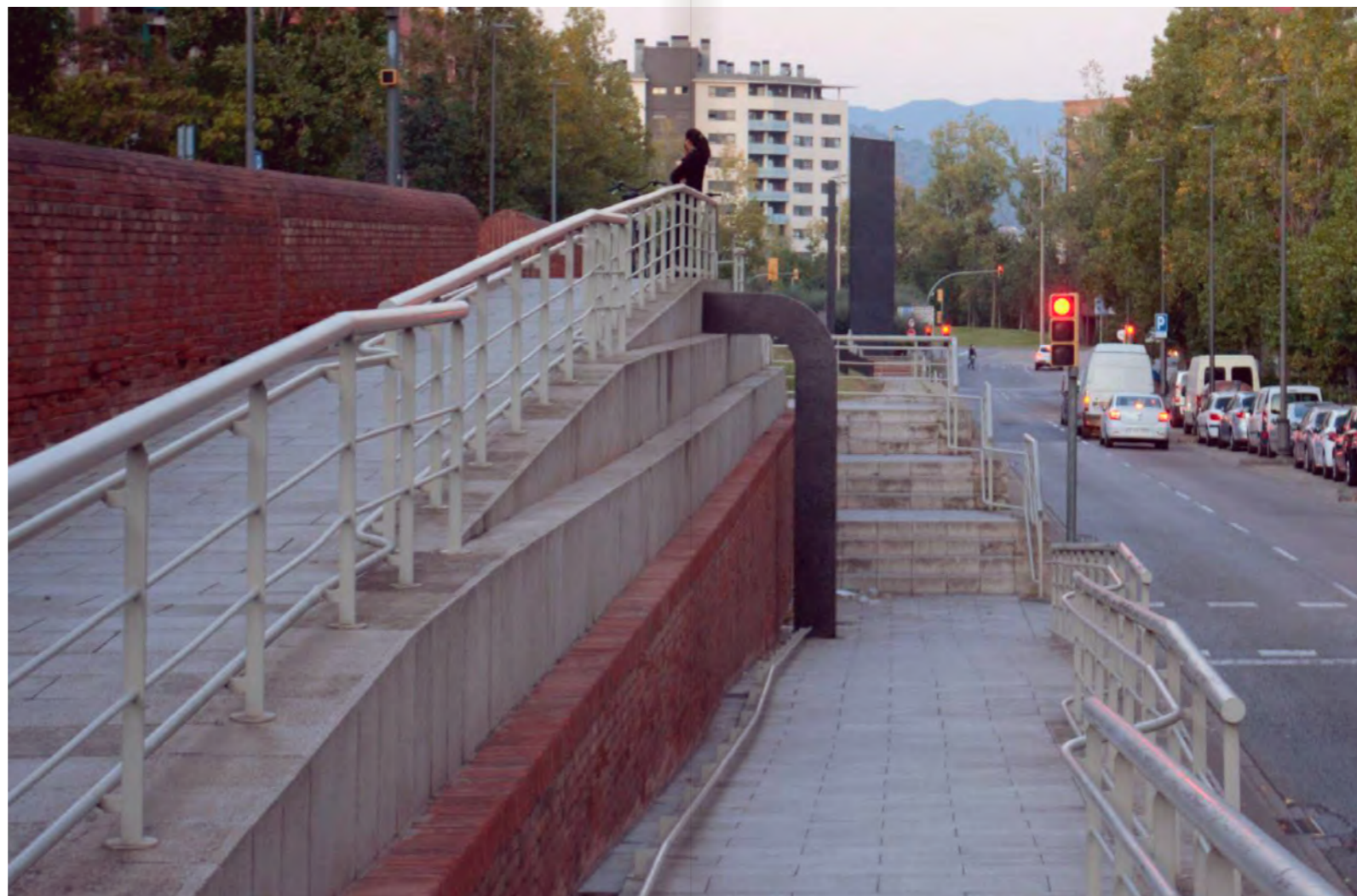
Imagen 32: Rampa y escalera, Av. Río de Janeiro. Fotografía del autor.
