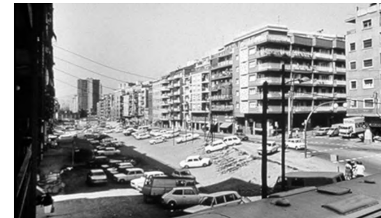
Imagen 43: Estado anterior al proyecto de Vía Julia. Fuente: http://www.bernardodesola.com/via-julia.html
