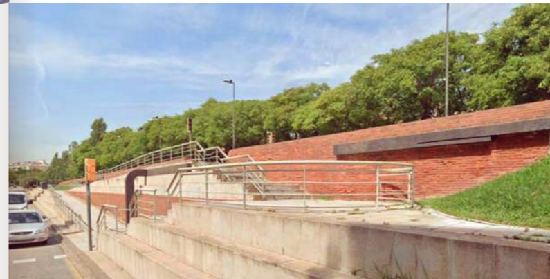
Imagen 36: Cruce central de la mediana. Imagen obtenida de Google Earth.
