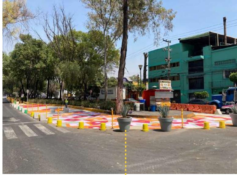
Elementos para segregación del flujo vehicular y peatonal del cruce: Hitos flexibles, materas medianas, trama de color con pintura.
