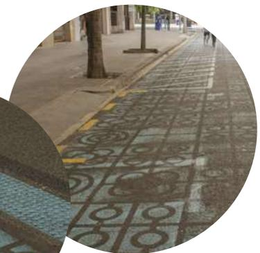
El suelo se demarca con pintura azul simulando la figura de los panots que son usados en diferentes calles del Ensanche.
