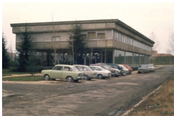
Imagen 2: Edificio del Centro de Cálculo
