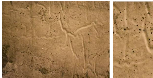
Granulometria fina, petges o arrugues marcades del plàstic arrugat i bombolles, de la cara interior del vitrall.
