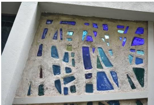
Morter d'unió amb l'estructura arquitectònica. (Vitrall d'estudi.) (Fotografies realitzades per Marta Golobardes, 2021)
