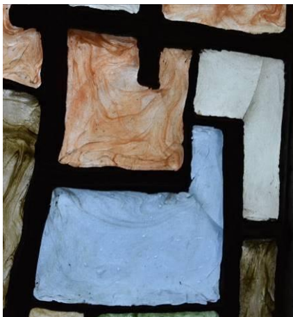
Dalles tipus Duxcrom del vitrall de ciment de l'església Sant Domènec, de Puigcerdà, realitzades per la fàbrica Padrós S.A. o Regio Pistrina . (Fotografies realitzades per Marta Golobardes, 2020.)
