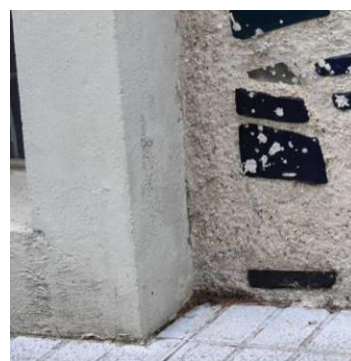
Morter d'unió amb l'estructura arquitectònica. (Vitrall d'estudi.) (Fotografies realitzades per Marta Golobardes, 2021)
