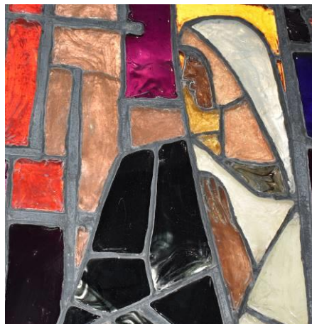
Dalles tipus Duxcrom del vitrall de ciment de l'església Sant Domènec, de Puigcerdà, realitzades per la fàbrica Padrós S.A. o Regio Pistrina . (Fotografies realitzades per Marta Golobardes, 2020.)
