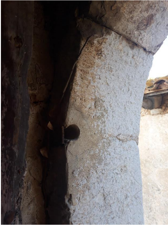
Fotografies 69 i 70: forats per la porta al marc de pedra de la porta, costat esquerre.
