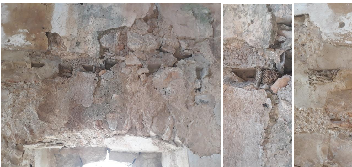
Fotografia 23: forats per a bigues de fusta sobre la porta. Fotografies 24 i 25: fragments de fusta conservats in situ.
