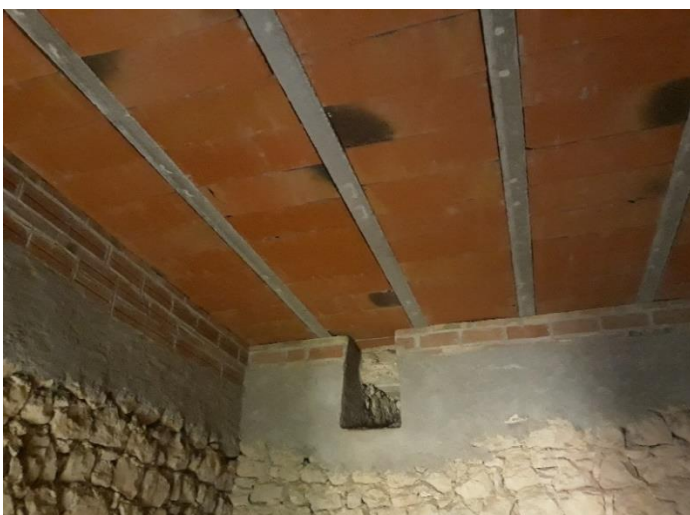
Fotografia 52: sostre de la planta baixa, completament nou.
