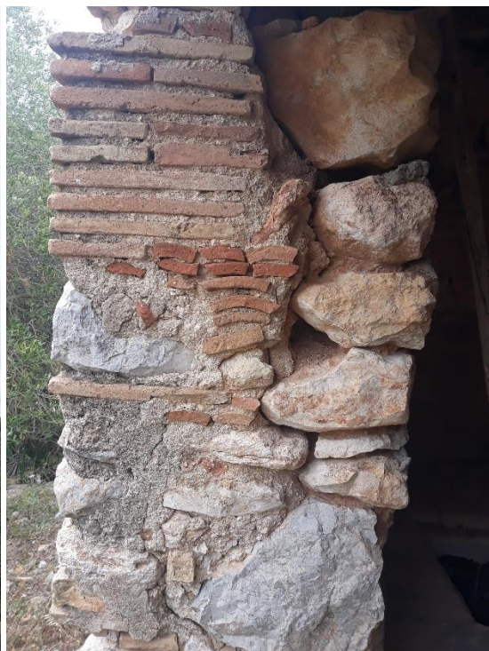
Fotografia 8: la paret sud de la torre. Es pot veure l'obertura emmarcada amb maons i fusta i la cobertura de totxanes. Fotografia 9: gruix de la paret a l'entrada de la paret sud. La part interior, igual que la resta de la torre, és de pedra, mentre que la part exterior ha estat recoberta posteriorment per maons.
