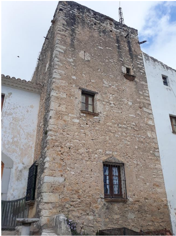
Fotografia 35: paret sud. Fotografia 36: paret oest. Amb les dues fotografies es poden veure totes les finestres, a més dels forats de pal a la part superior.
