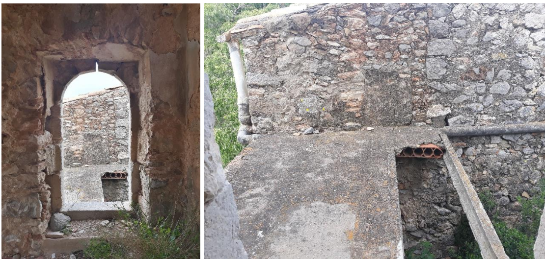
Fotografia 19: la porta alçada vista des de l'interior. Fotografia 20: passarel·la de formigó que actualment uneix la porta de la torre amb la masia. Es pot veure una obertura a la paret de la masia actualment tapiada.
