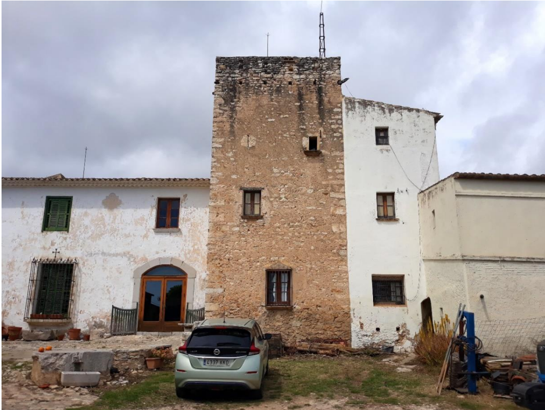
Fotografia 33: la torre vista des del davant de la masia, a la banda sud-oest.
