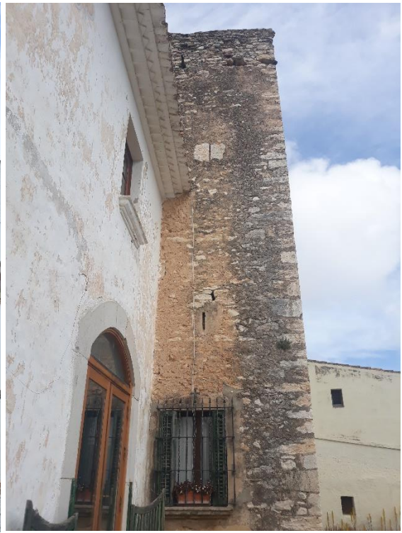
Fotografia 35: paret sud. Fotografia 36: paret oest. Amb les dues fotografies es poden veure totes les finestres, a més dels forats de pal a la part superior.
