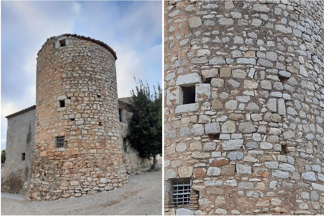
Fotografies 82 i 83: els quatre buits a l'exterior de la torre.
