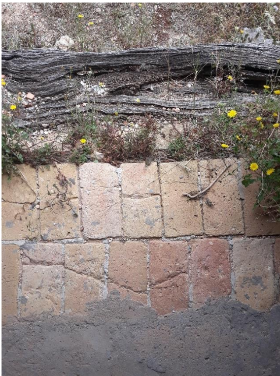
Fotografia 12: vista del terra des de l'obertura a la paret sud. A part de la fusta de l'obertura, s'hi veuen les rajoles que cobrien el terra i que actualment es veuen a les parts perifèriques del terra i, a la part inferior de la foto, el recobriment de ciment que fa de sostre al cup de vi.
