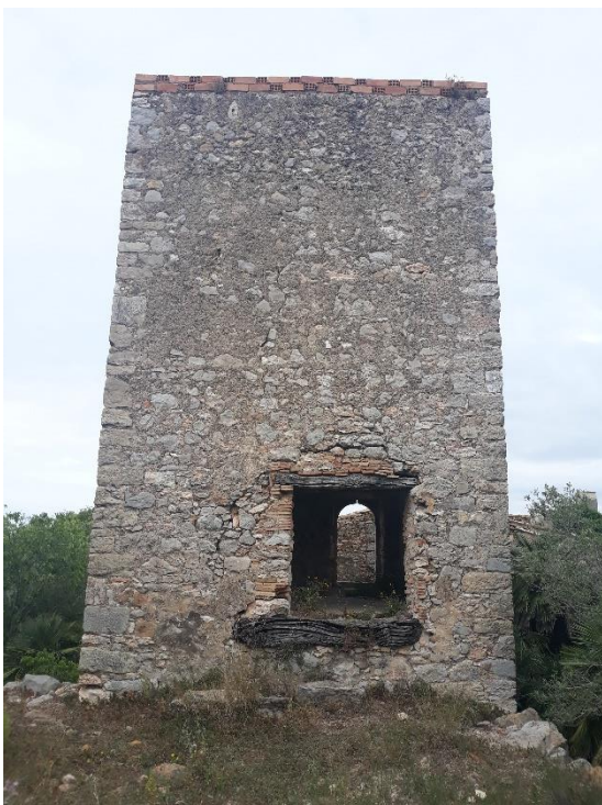
Fotografia 8: la paret sud de la torre. Es pot veure l'obertura emmarcada amb maons i fusta i la cobertura de totxanes. Fotografia 9: gruix de la paret a l'entrada de la paret sud. La part interior, igual que la resta de la torre, és de pedra, mentre que la part exterior ha estat recoberta posteriorment per maons.
