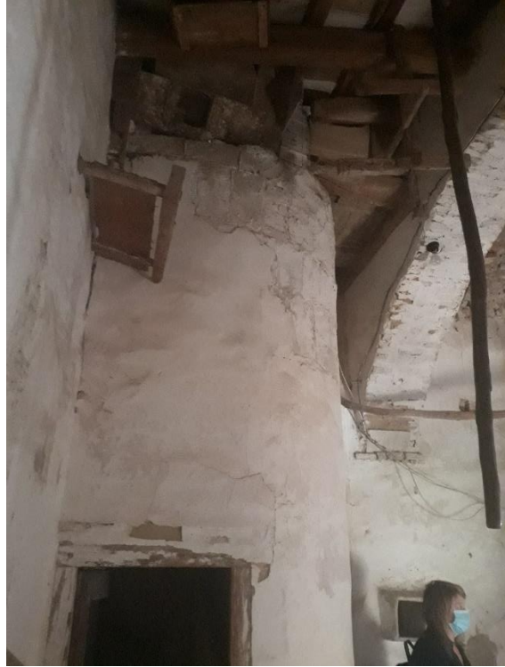
Fotografies 39 i 40: construcció cilíndrica al colomar a l'interior de la qual hi ha les escales de cargol per accedir al terrat de la torre.
