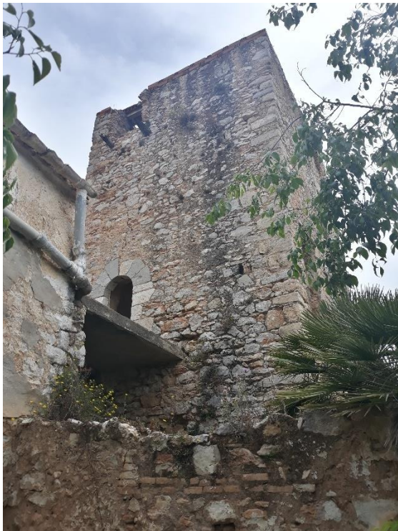
Fotografia 6: la paret nord de la torre. Es pot veure l'entrada alçada i la finestra superior. Fotografia 7: la paret est de la torre, completament llisa, i part de la masia al fons.
