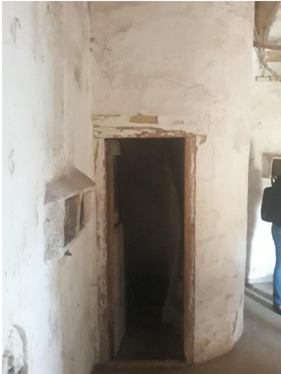
Fotografies 39 i 40: construcció cilíndrica al colomar a l'interior de la qual hi ha les escales de cargol per accedir al terrat de la torre.
