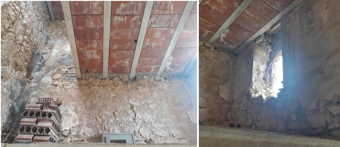
Fotografia 26: visió del segon pis. s'hi pot veure un dels sostres moderns i el revestiment. A diferència del revestiment a la resta de la torre, de color blanc; a la paret sud del segon pis és de tonalitat negra o gris. Fotografia 27: finestra a la paret oest del segon pis.
