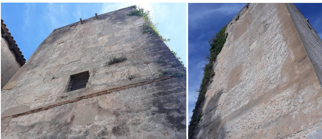
Fotografia 53: l'exterior de la torre vista des del nord. Fotografia 54: la paret oest vista des de l'exterior. El sostre del primer pis de l'interior també és visible a l'exterior. A més, a la paret oest es veuen dues obertures tapiades.
