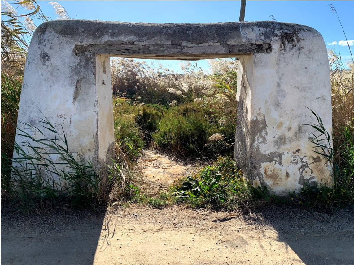
Figura 12: Portal de feixa clàssic ben conservat però parcialment absorbit per la vegetació a causa de l'abandonament. Fotografia pròpia realitzada el 02/11/2019.
