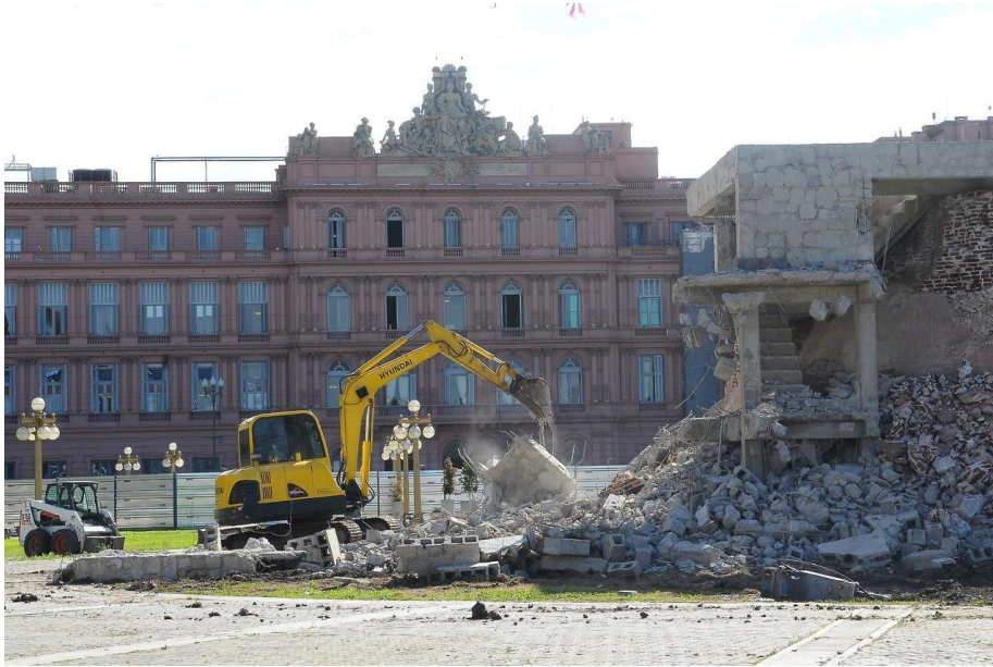
Anexo 1. Demolición del pedestal del Monumento a Colón de Buenos Aires
