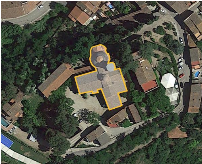
Il·lustració 39: Vista aèria de l'església parroquial de Santa Maria de Piera (Foto: earth.google.com)
