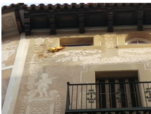
Fotografia 3: Desperfectes en l'esgrafiament de Cal Víctor Riu, 2021 (Foto: Martí Coral)
