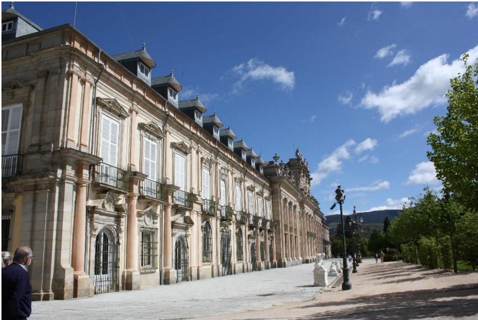
Figura 12: Façana cap al jardins vista des de la cantonada sud del Palau.
