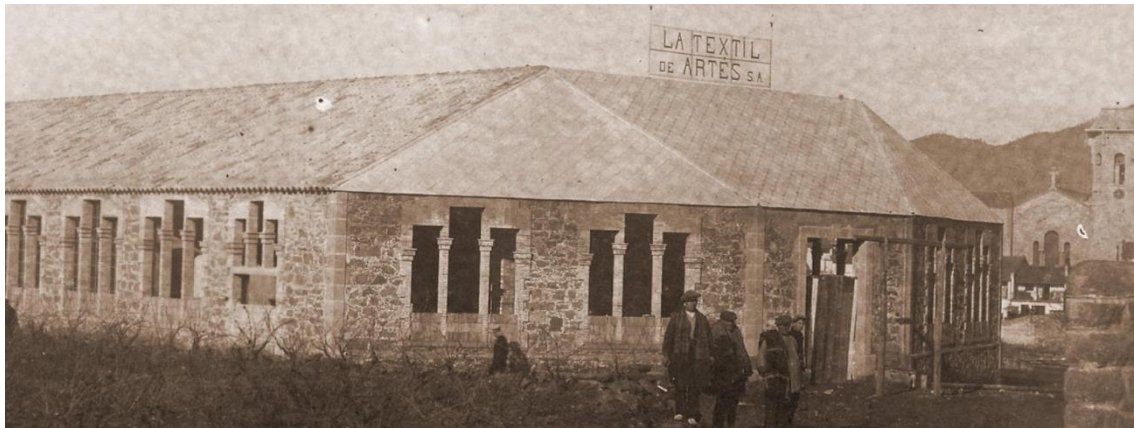
Figura 2. Fotografia d'un estat avançat de les obres de construcció de la fàbrica La Tèxtil d'Artés S.A., 1918. Font: Fons fotogràfic de l'AMA.
