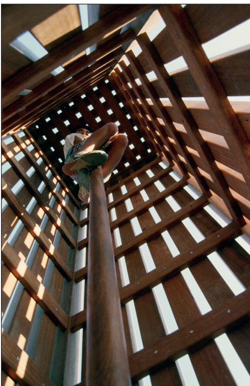
Construcció de la Torre del Parc de l'Albereda
