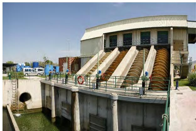
Ilustración 224. La estación de bombeo intermedio en Sant Joan Despí. Fuente: Aigües de Barcelona.
