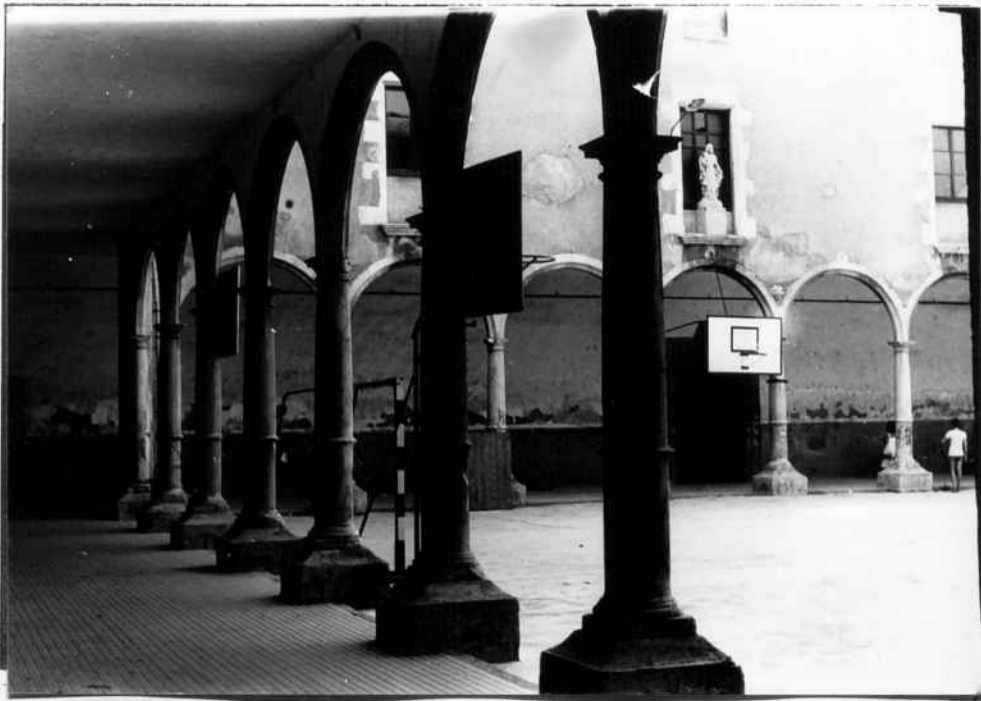
Vista parcial dels claustres. Avui utilitzat per una escola com a pati d'esgarjo.
