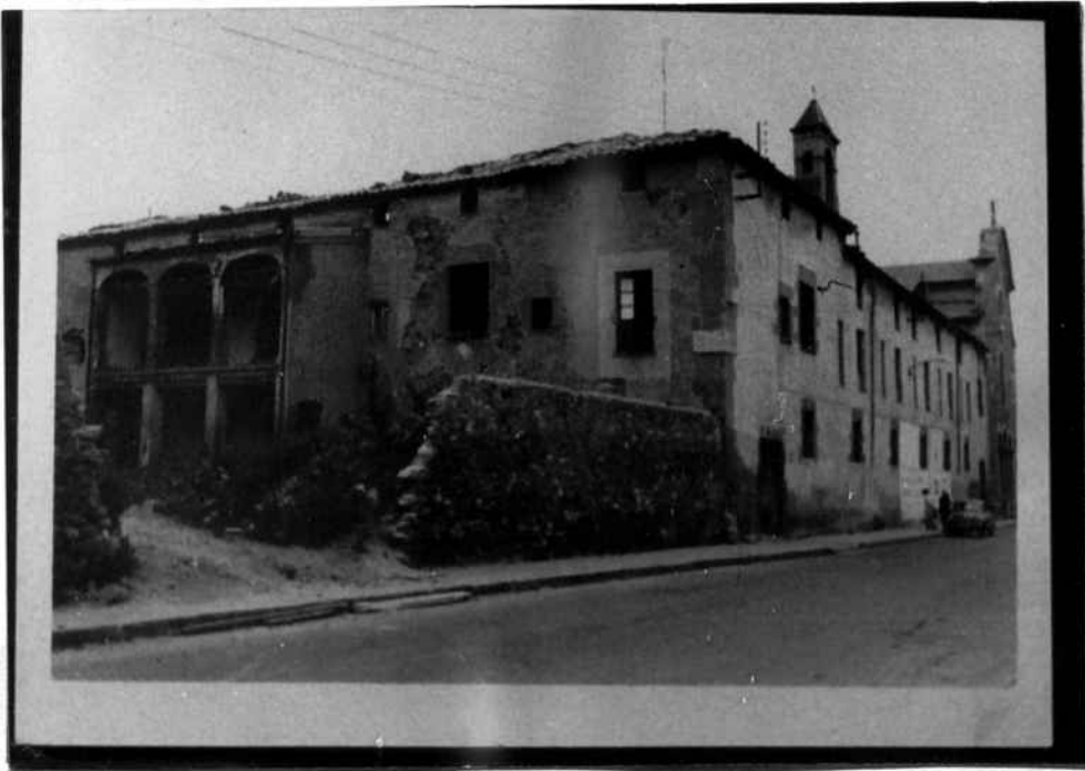
Vista de la façana principal i la paret de mig-dia del convent poc abans de la seva demolició.
