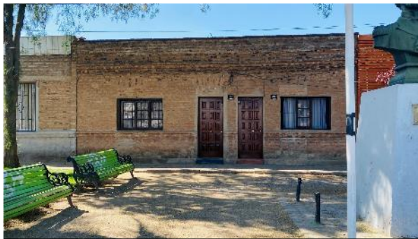
Vivienda fachada continua
