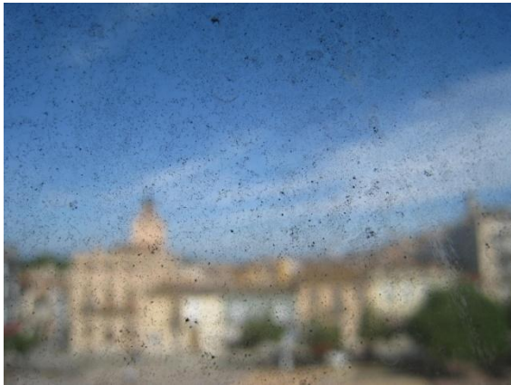
Fig. 31 Dipòsits superficials en un dels vidres de la planta superior. (Font pròpia)
