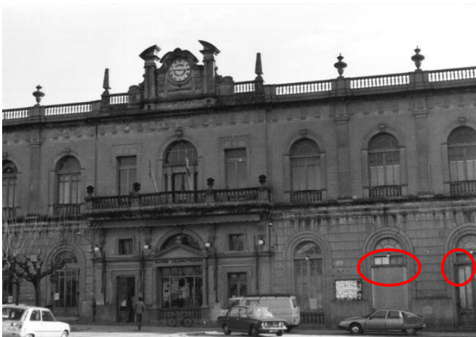
Fig. 37: Imatge presa el 1983 on s'aprecia (destacat en vermell) la modificació en l'amplitud de les obertures a la planta baixa. Reproducció autoritzada per l'AMLL
