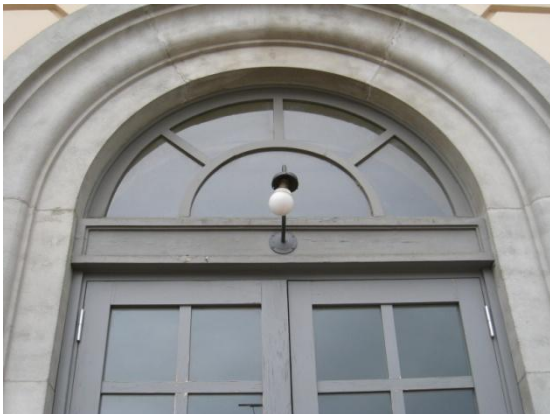
Fig. 33 Imatge actual de la portalada central en el lateral esquerra (Font pròpia)
