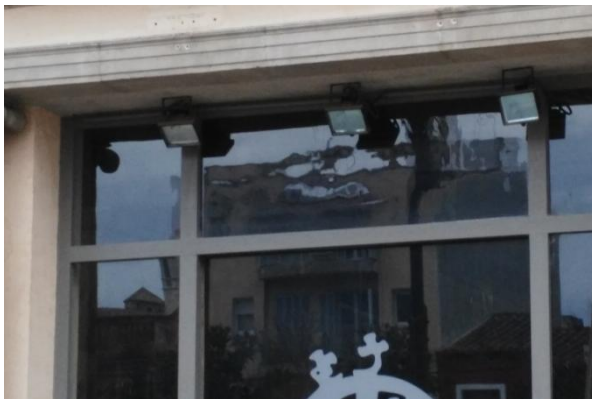
Fig. 17b: Finestral a la part central on s'aprecia la diferència en els reflexos del vidre antic i modern (Font pròpia)
