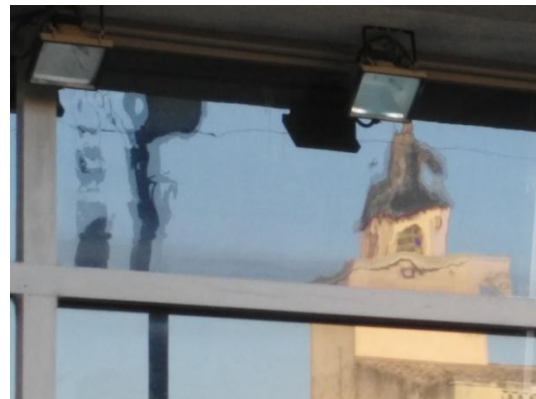
Fig. 17c: Una altra imatge del finestral amb la distorsió de les imatges que s'hi reflecteixen (Font pròpia)
