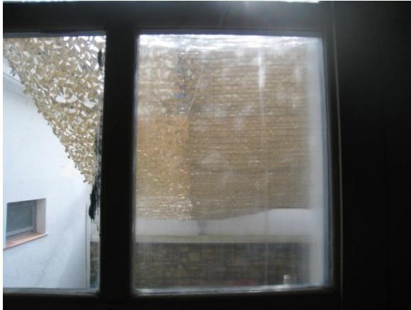
Fig. 29 Pèrdua reintegrada amb material plàstic (a la dreta de la imatge). Font pròpia
