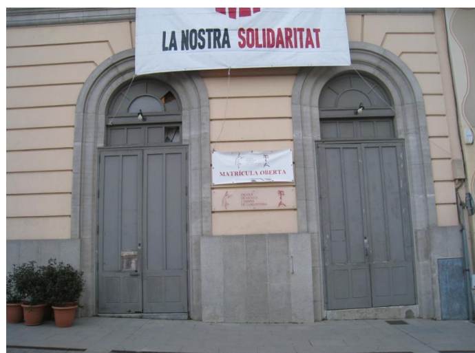
Fig 38: Estat actual de les portes d'accés a les aules de música i dansa. El tapiat en fusta figura també en la imatge de l'any 1983 (fig. 37)- Font pròpia
